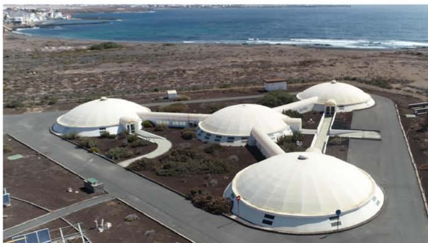
Instalación desaladora de Pozo Izquierdo (Gran Canaria).
